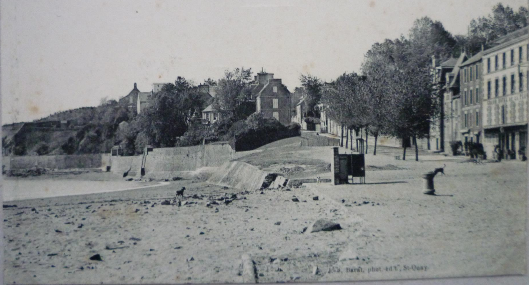
1332. Portrieux-les-Bains (C.-du-N.) - Grand Hôtel de la Plage route de la Gare
